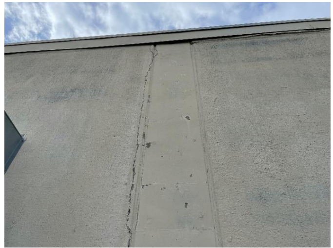
CS-S3: Cracked Concrete Walls
